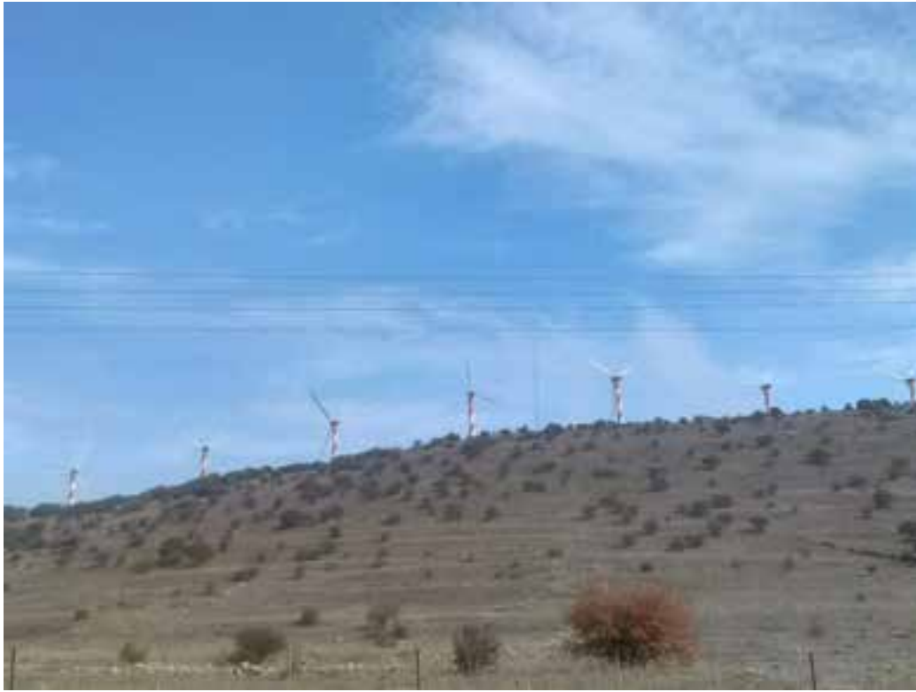
مزرعة رياح في الجولان (وهي الوحيدة في الجولان) قرب القنيطرة. هذه التوربينات، يصل ارتفاع محور كل منها لحوالي 30 متراً. وتوربينات المشروع، يصل ارتفاع محور كل منها لحوالي 125 متراً. (من أرشف المرصد)
