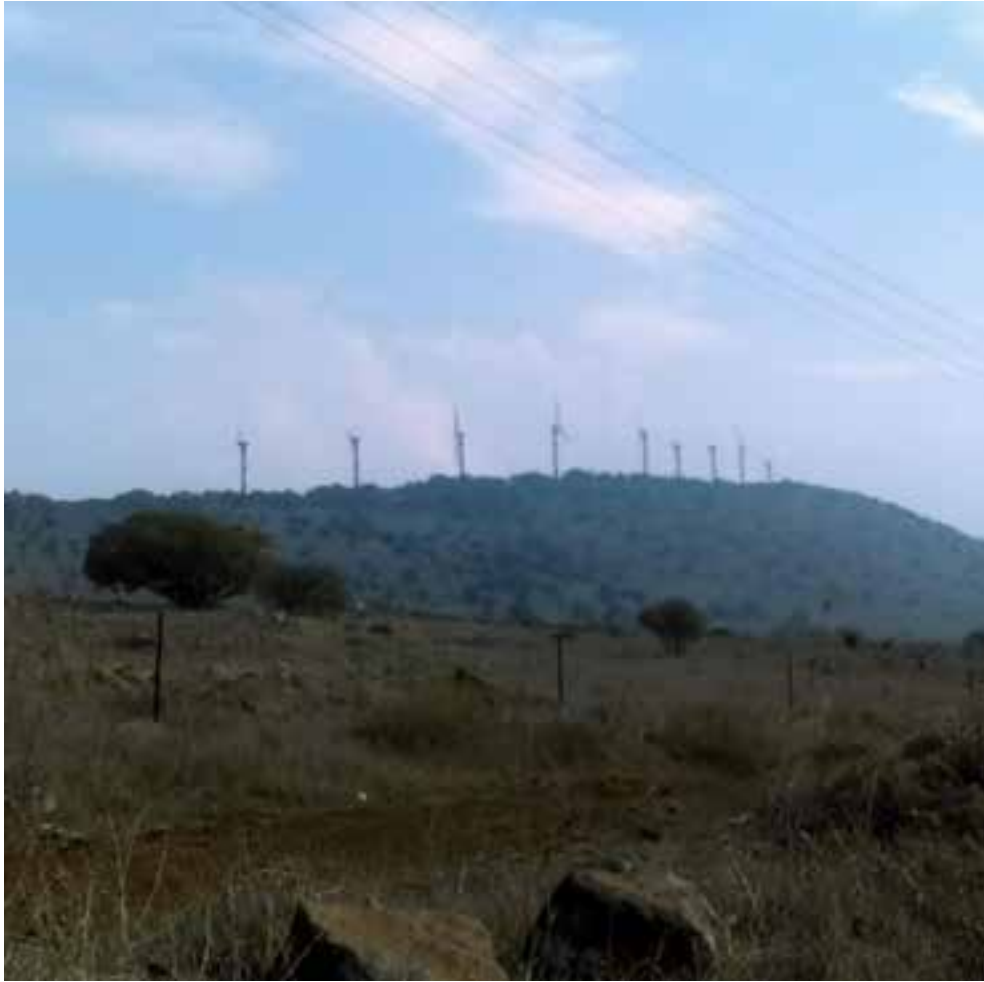
مزرعة رياح في الجولان (وهي الوحيدة في الجولان) قرب القنيطرة، هذه التوربينات، يصل ارتفاع محور كل منها لحوالي 30 متراً. وتوربينات المشروع، يصل ارتفاع محور كل منها لحوالي 125 متراً. (من أرشف المرصد)
