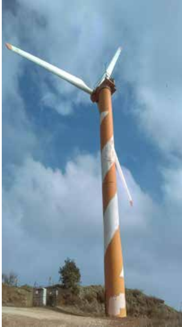
توربينة رياح بمزرعة رياح في الجولان (وهي الوحيدة في الجولان) قرب القنيطرة. هذه التوربينة، يصل ارتفاع محورها لحوالي 30 متراً. وتوربينات المشروع، يصل ارتفاع محور كل منها لحوالي 125 متراً. (من أرشف المرصد)
